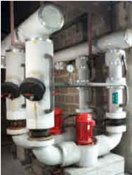
Beispiel für den Einsatz des Sanftanlassers Altistart 22 in einer Pumpstation
