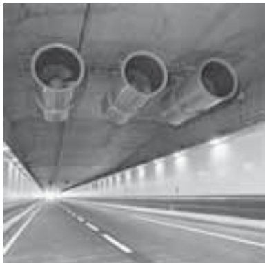
Lüftungstechnische Anlage
